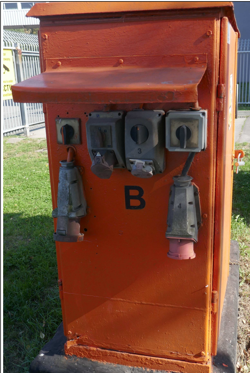
Fot. 4 Rozdzielnice nabrzeżowe - BON.
